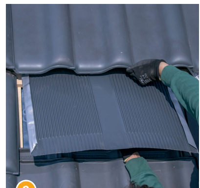
9 Ausparung des Stützblechs auf der oberen Querlatte einhängen.
