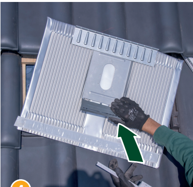
4 Höhe der Beta-Platte durch Umfalzen des Stützblechs auf der Rückseite entsprechend anpassen.
