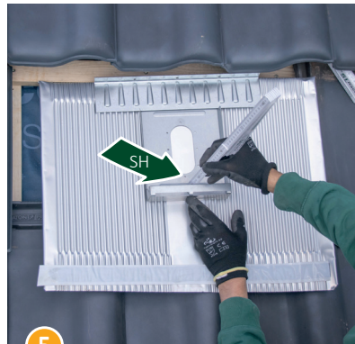
5 Dachplattenhöhe (DH) = Stützblechhöhe (SH).
