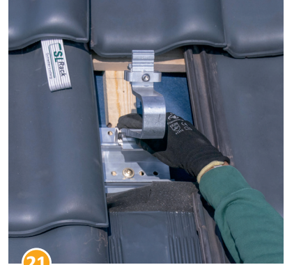
21 Dachhaken in Fuß einhängen.
