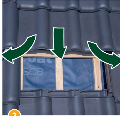
2 ...unter der oberen Reihe so plazieren, dass die Querlattung gut einseh- und erreichbar ist.
