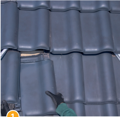
1 Dacheindeckung im Montagebereich (max. 3 Ziegel) aufdecken und die äußeren Dachplatten....
