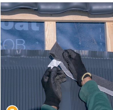
7 Schutzfolie des Klebestreifens auf der Unterseite des Schaumstoffkeils abziehen.
