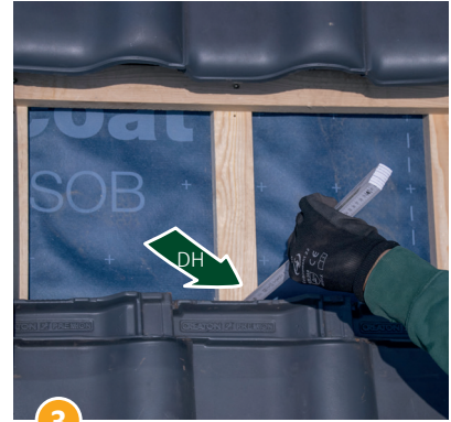
3 Ermitteln der auszugleichenden Dachplattenhöhe (DH).
