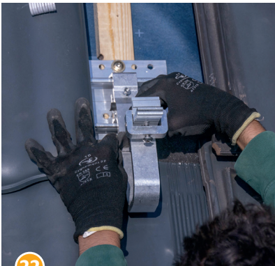
22 Einschnitt am Schaumstoffkeil um den Dachhaken...
