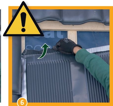
6 Die hintere Blechkante leicht nach hinten drücken.
